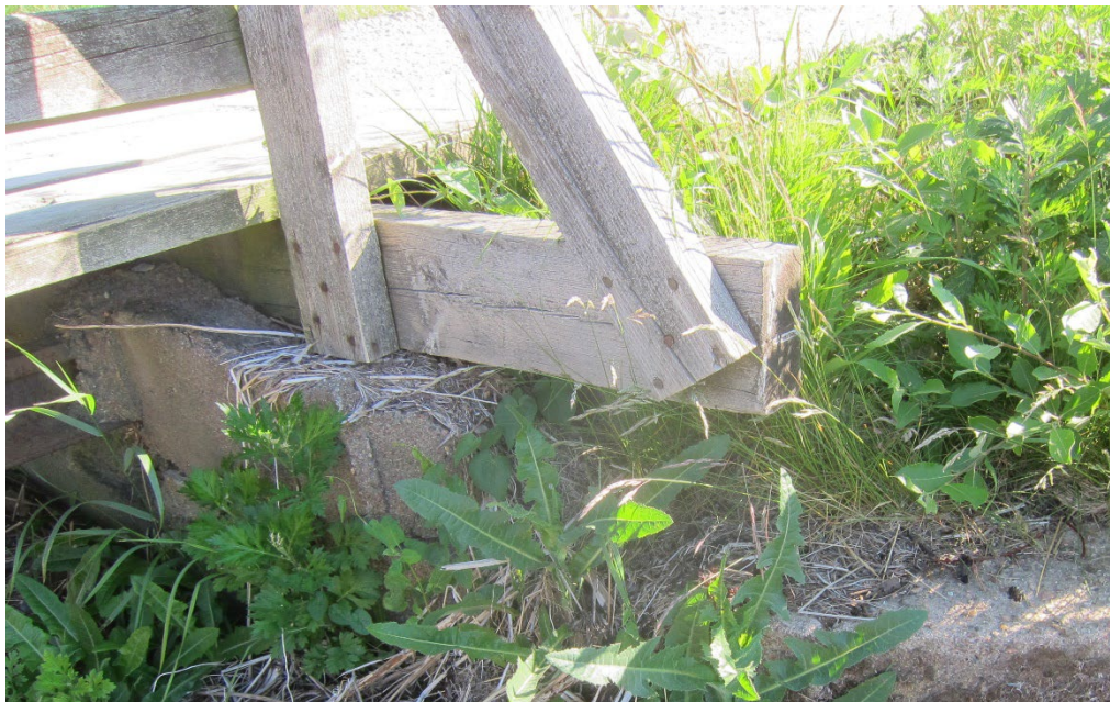
Träfarbanans underliggande tvärplanka behöver hållas fuktfri.
