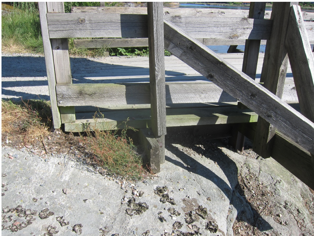
Västra stödet står stabilt på berg, trädelar behöver dock hållas rena från grus och vegetation samt inoljas med jämna mellanrum.
